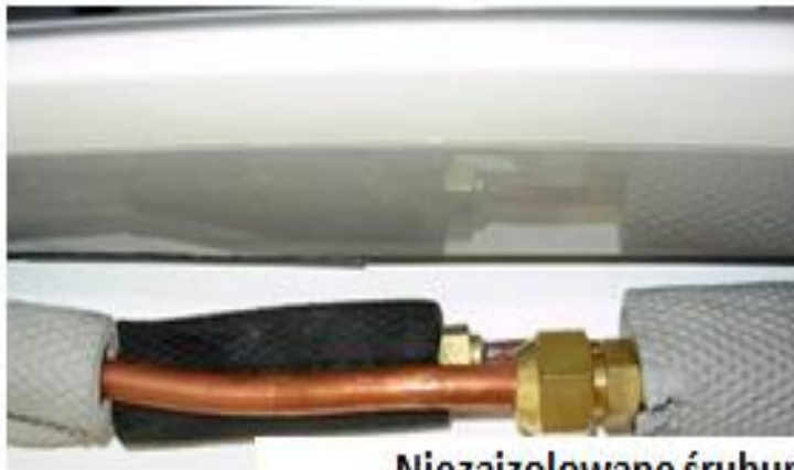
Niezaizolowane śrubunki przy jednostce wewnętrznej.
